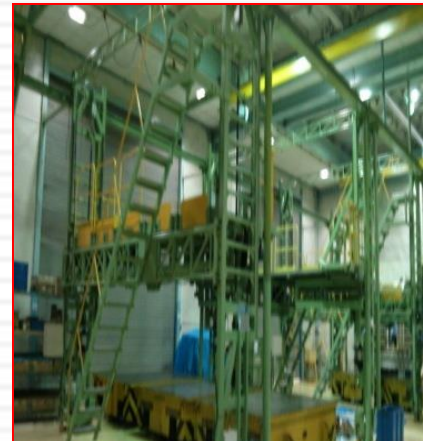
Plateforme de Montage du Noyau des Bobines
